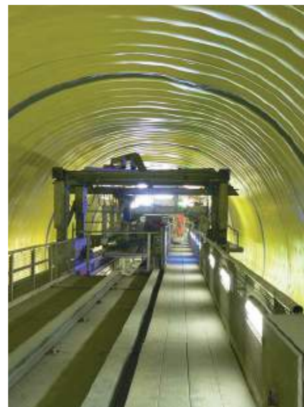
TÚNEL SÃO GOTARDO, SUÍÇA
